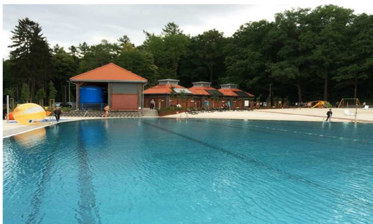
Fot. 4 "Leśny Potok" - Zrewitalizowany zbiornik retencyjny – część rekreacyjna.
