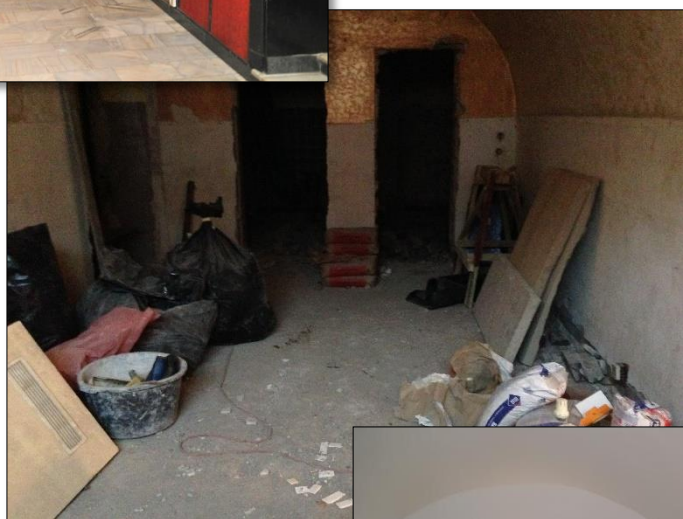
w trakcie renowacji
