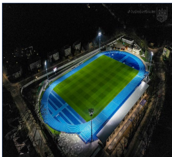
Fot. 15 Stadion Miejski ul. Spółdzielcza
