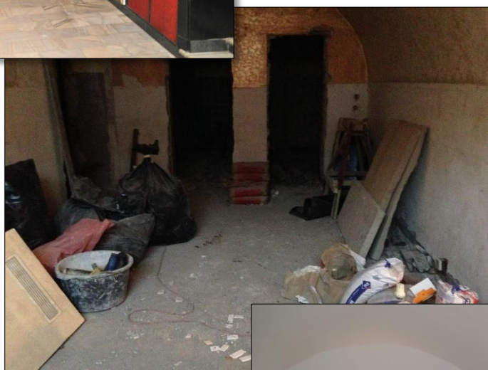
w trakcie renowacji
